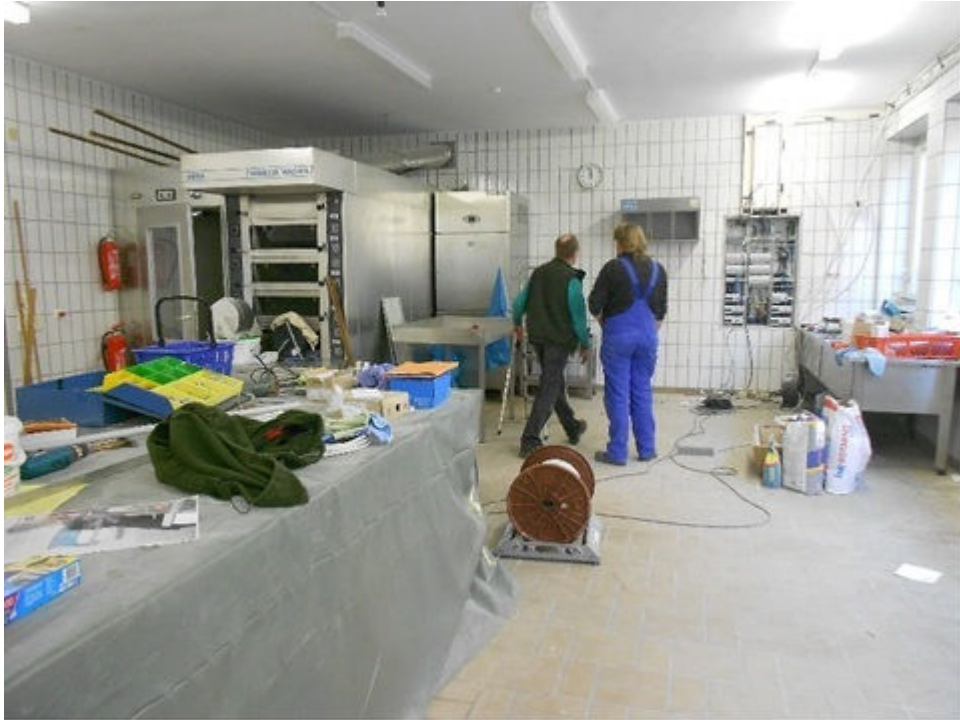
Die Sanierungs- und Modernisierungsarbeiten an der Backstube der Elisabeth-Selbert-Schule sind inzwischen erfolgreich abgeschlossen. Foto: ESS
