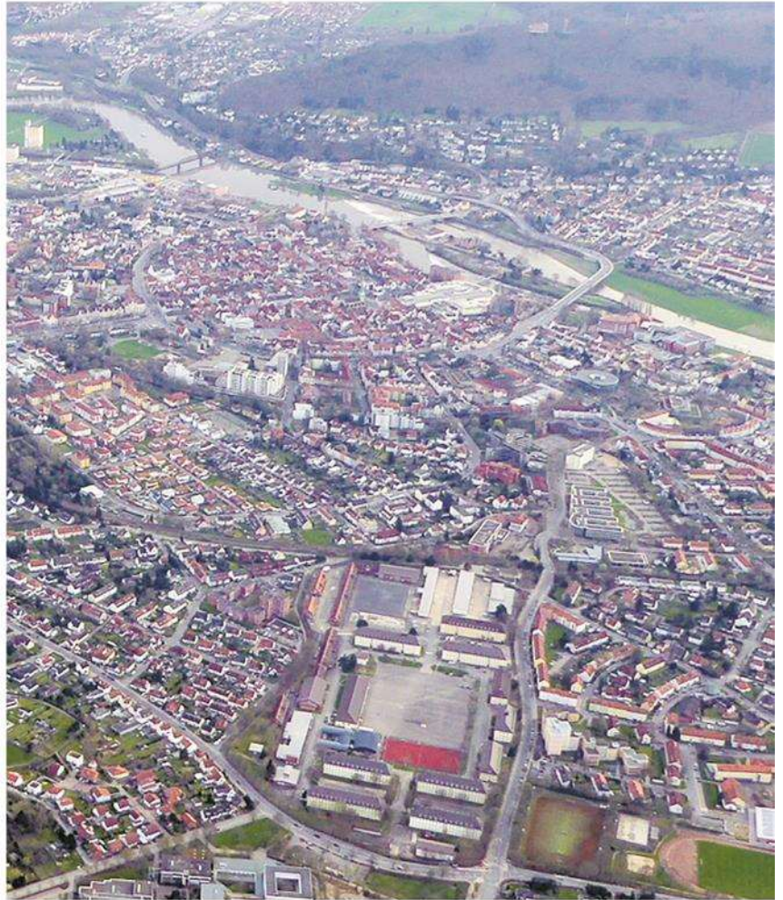
Auf dem nördlichen Teil des Linsingen-Geländes an der Hamelner Basbergstraße, hier am unteren Bildrand, soll der Neubau der Elisabeth-Selbert-Schule entstehen. Die Kasernengebäude sollen abgerissen werden.
